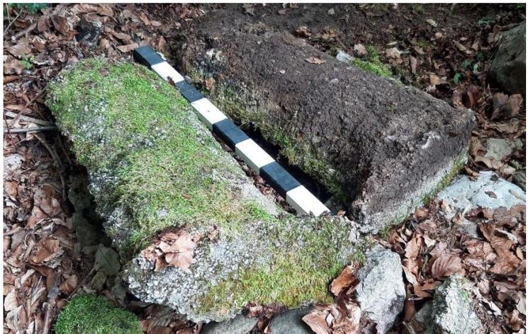
Hier gut sichtbar: Die beiden Platten sind unterschiedlich lang und die Schnittflächen nicht deckungsgleich. Die obere zeigt einen Abdruck wie von einer Holzschalung. Die untere wirkt geschliffen. Beide haben längsseitig Brauen und sind oben dachziegelförmig.
